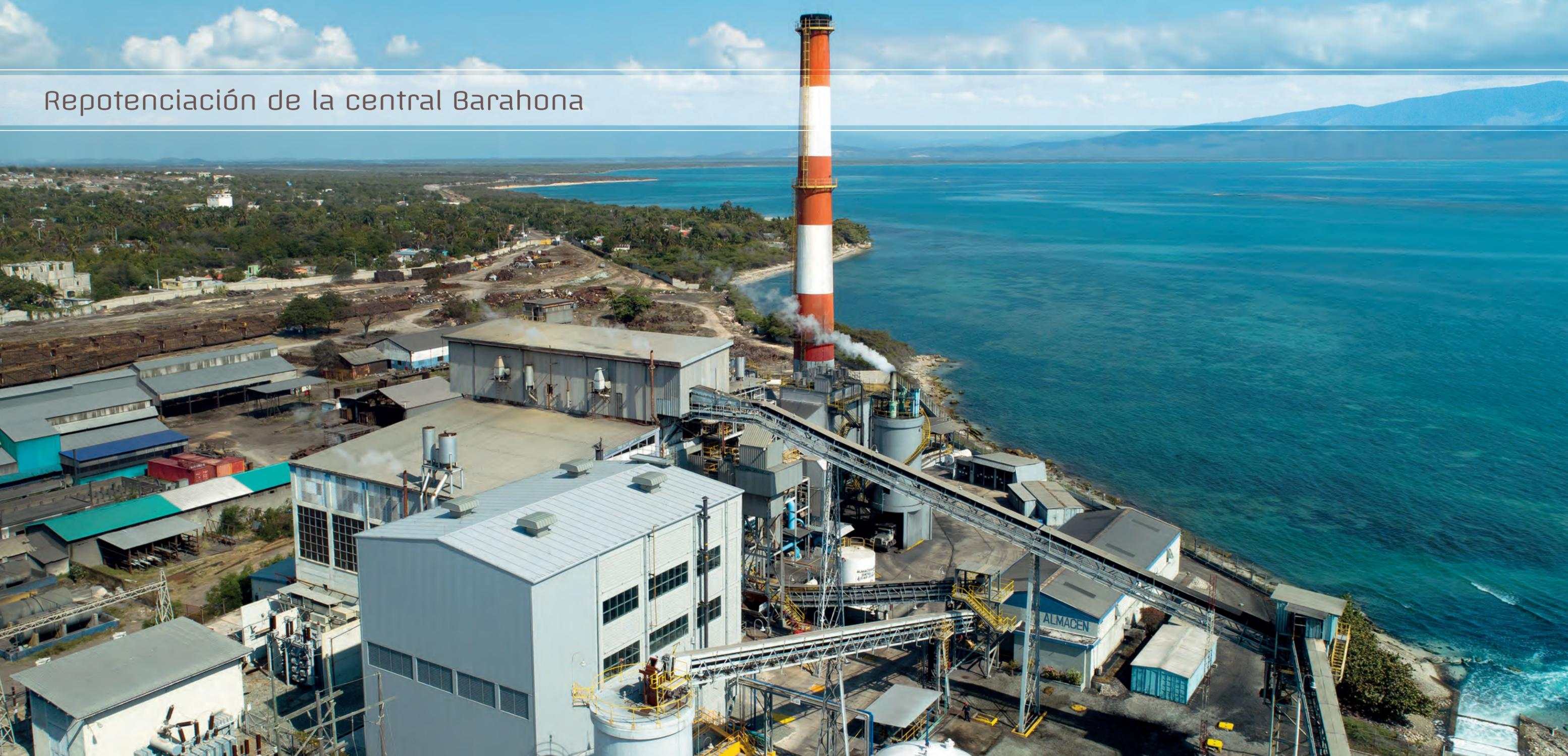
En 2018, EGE Haina concluyó los trabajos de interconexión del nuevo turbogrupos de su planta Barahona, tras culminar el proyecto de repotenciación iniciado en diciembre de 2016, que abarcó el reemplazo de la turbina, el generador y el condensador de esa central, con una inversión aproximada de 30.3 millones de dólares.
