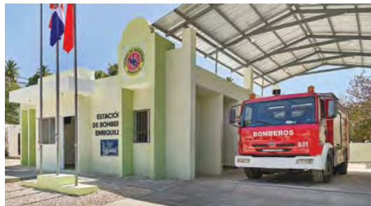
EGE Haina construyó la Estación de Bomberos del municipio Enriquillo, inaugurada en 2023, y que tuvo un costo de 13 millones de pesos.
