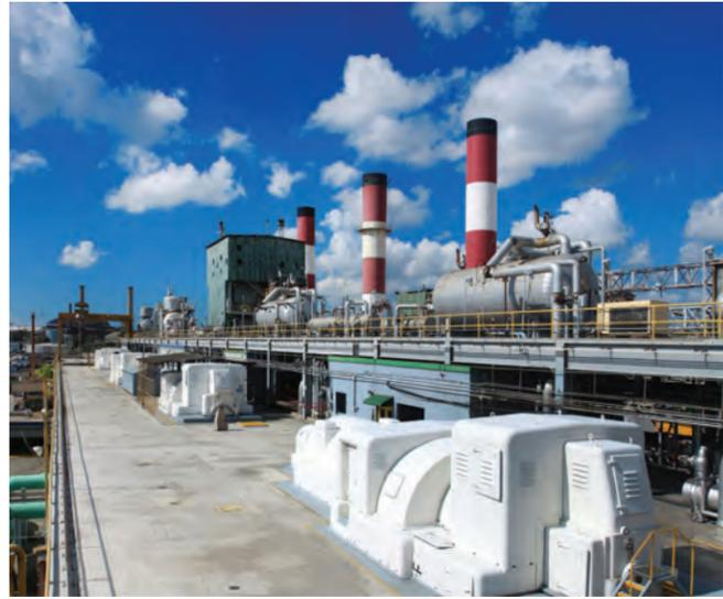
La planta de Haina se encuentra en el municipio de Haina, Provincia de San Cristóbal, adyacente a la sección suroeste de la ciudad de Santo Domingo y hacia la costa. La planta está compuesta por dos unidades generadoras con turbinas de vapor que utilizan fuel oil #6, Haina I y Haina IV, y una turbogás que opera con Diesel Oil, Haina GT.
