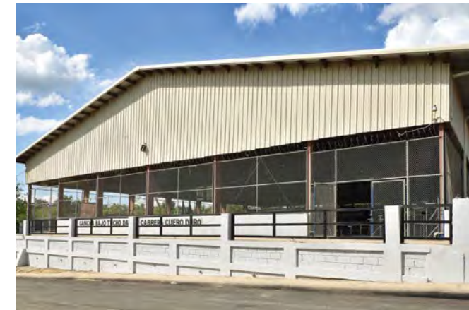
Muro de contención de la cancha bajo techo Danilo Cabrera, Esperanza
