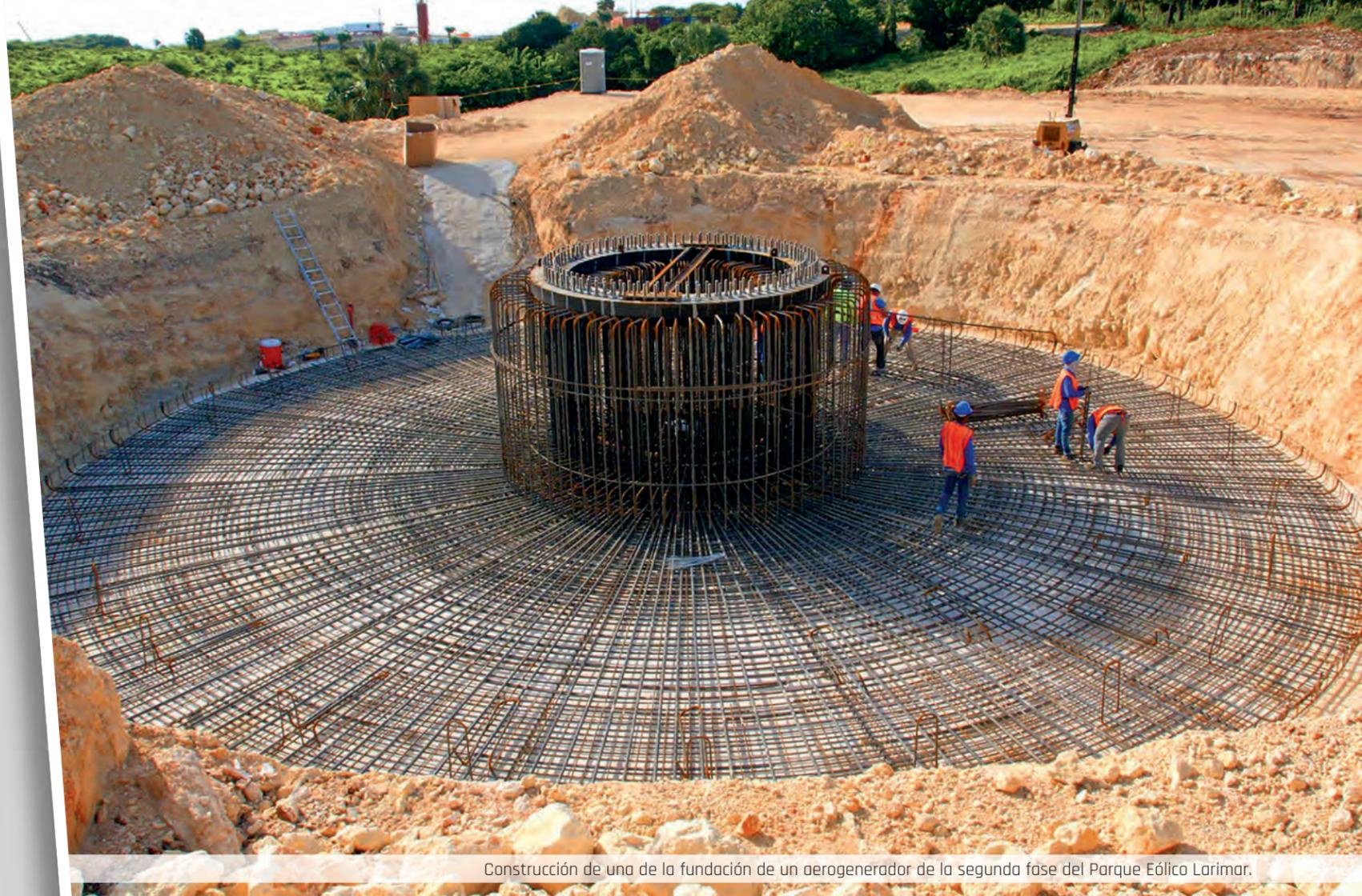
Construcción de una de la fundación de un aerogenerador de la segunda fase del Parque Eólico Larimar.
