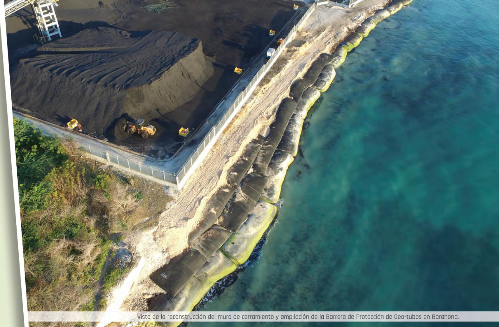
Vista de la reconstrucción del muro de cerramiento y ampliación de la Barrera de Protección de Geo-tubos en Barahona.
