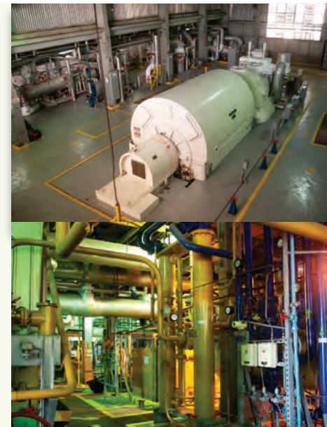
ARRIBA: VISTA EN PLANTA DEL TURBOGENERADOR DE LA UNIDAD No. 2 EN PUERTO PLATA. ABajo: ÁREA DONDE SE UBICAN LOS EQUIPOS AUXILIARES EN EL PRIMER NIVEL DE LA PLANTA DE PUERTO PLATA. TAMBIÉN SE OBSERVAN LOS ENFRIADORES DEL SISTEMA DE LUBRICACIÓN DEL TURBOGENERADOR.
