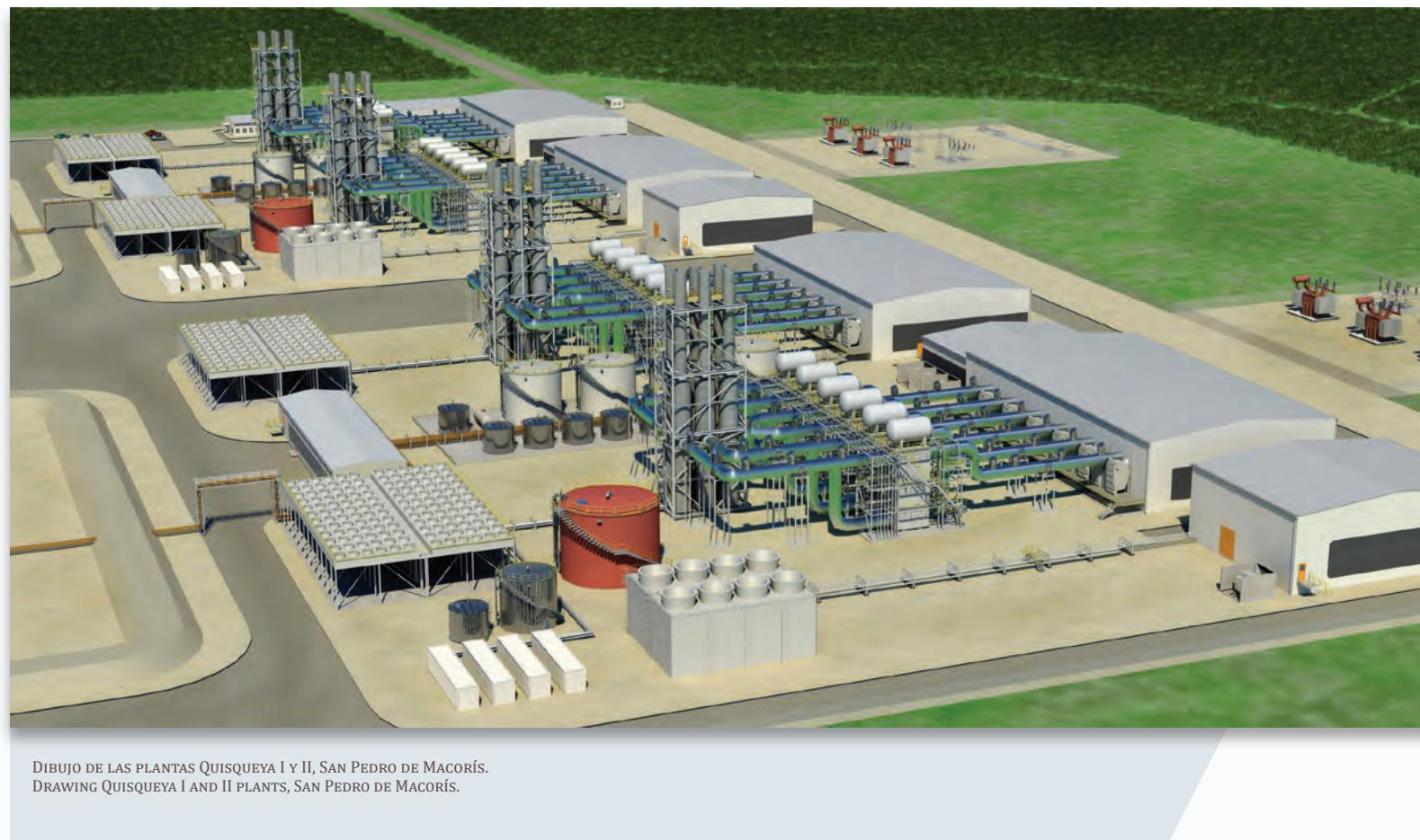
composición de **12** motores de combustible dual (fuel oil /gas natural) acoplados a una turbina de vapor, lo que constituye una tecnología de ciclo combinado sin precedentes de uso en el país.
