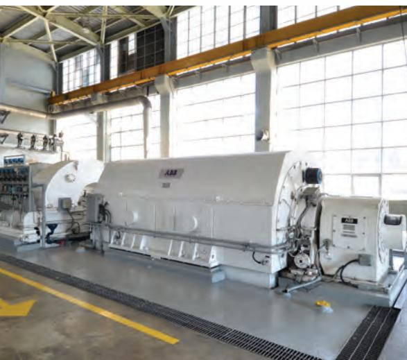
GENERADOR PRINCIPAL ACOPLADO A LA TURBINA DE VAPOR, EN LA CENTRAL DE BARAHONA.
